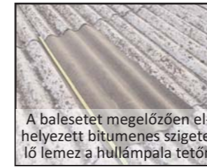
A dilatáció javítása (munkavédelmi hatóság felvétele)
